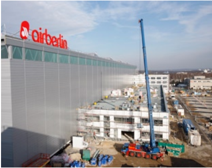
Die neue Halle 7. Nach Fertigstellung bietet sie Platz für drei Großraumflugzeuge gleichzeitig
